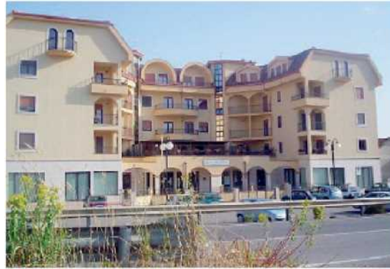
La sede dell'Agenzia delle Entrate a Enna bassa in contrada Ferrante (palazzo delle Arcate)
